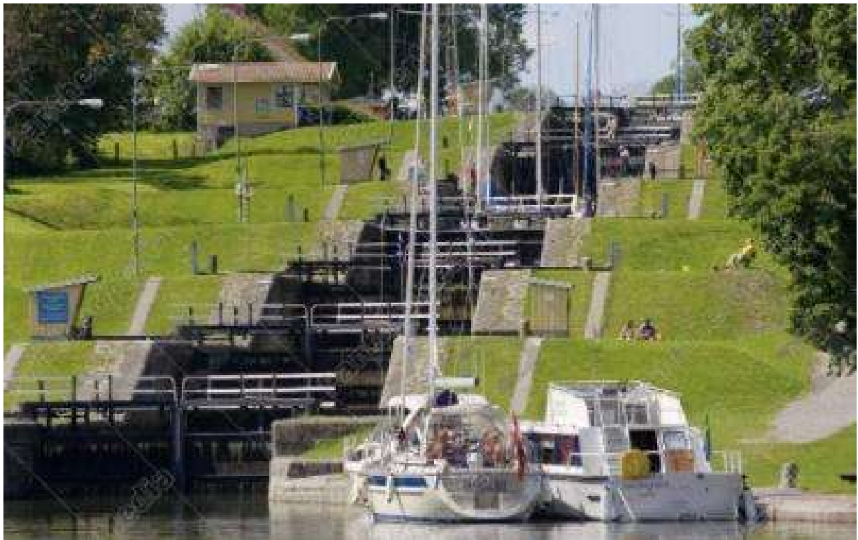
Die Schleusentreppe bei Bergen
